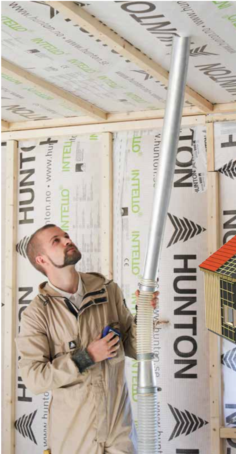
Illustrationen viser væg blæseisoleret, med Træfiberisolering.
