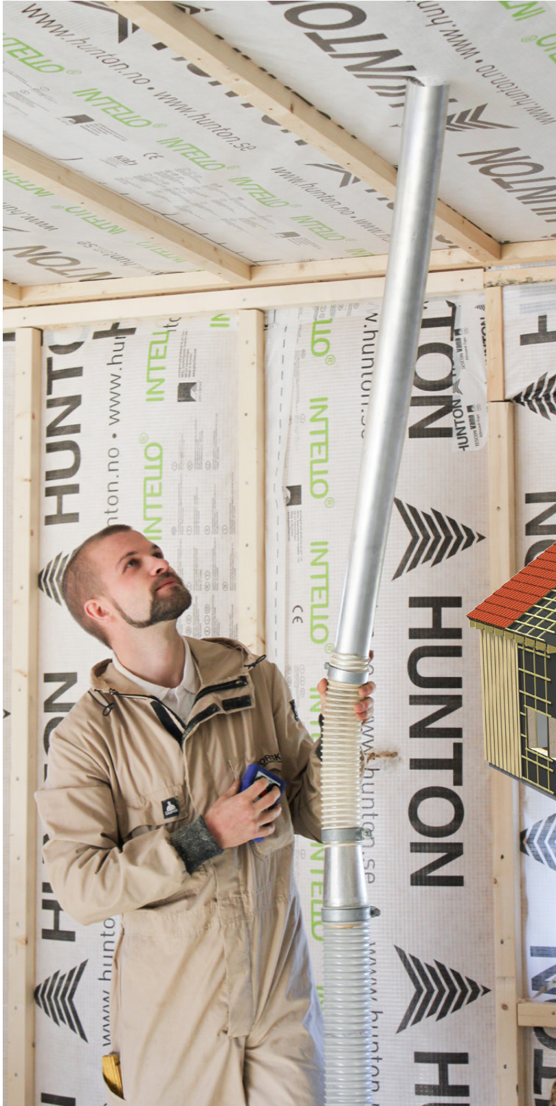
Illustrationen viser væg blæseisoleret, med Træfiberisolering.
