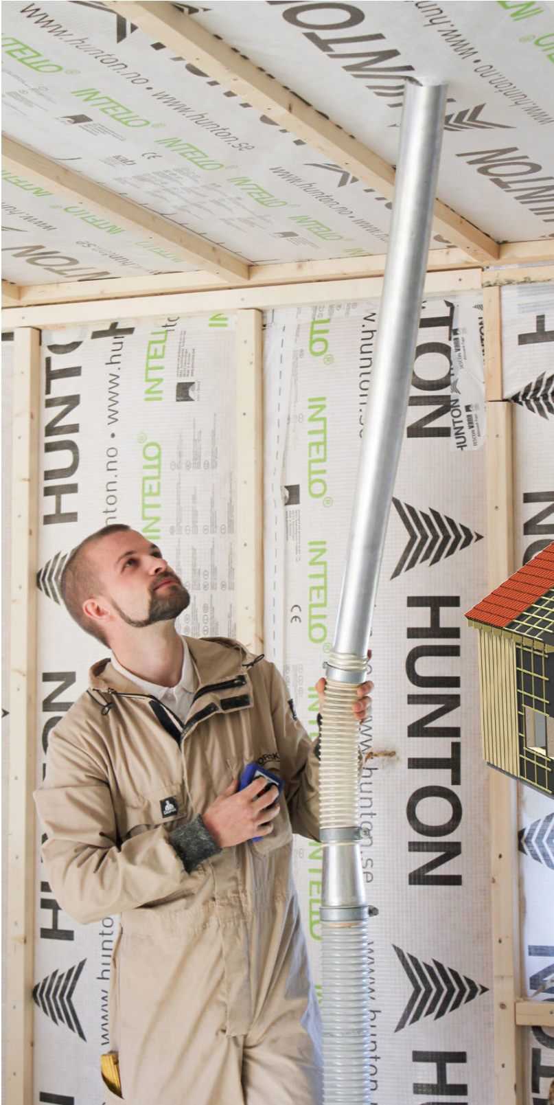
Illustrationen viser væg blæseisoleret, med Træfiberisolering.
