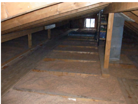
Eksempel: loft, før og efter blæsning.
