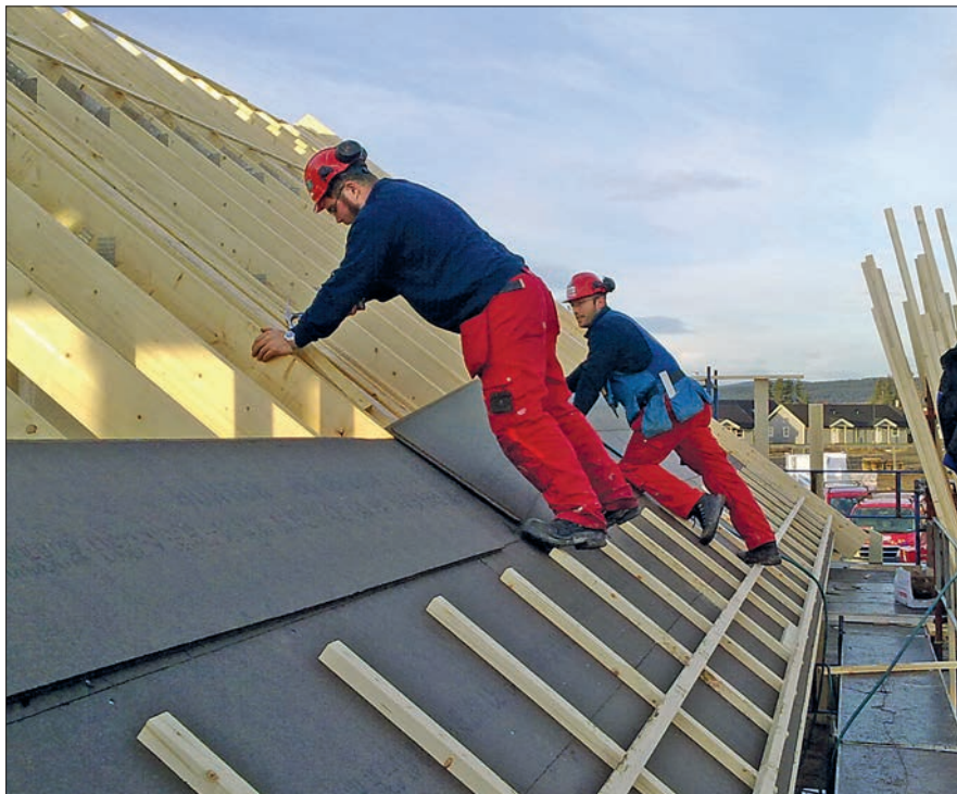
Levyväinen lämpöä eristävä Hunton Sarket aluskate soveltuu asennettavaksi suoraan kiinni lämmöneristeeseen, ilman alapuolista tuuletusväliä
