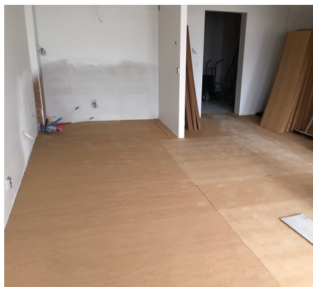
Levyt asennetaan kelluvaksi rakenteeksi. Latominen on nopeaa.
