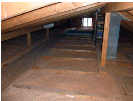
Esimerkki katosta ennen ja jälkeen puhalluksen.
