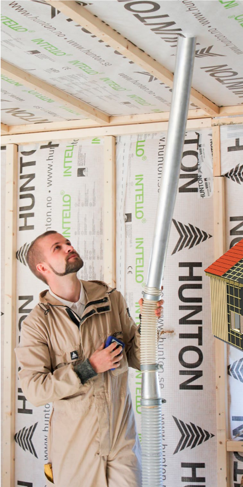
Kuvassa näytetään Nativo puukuitueristeellä puhallettu seinä.
