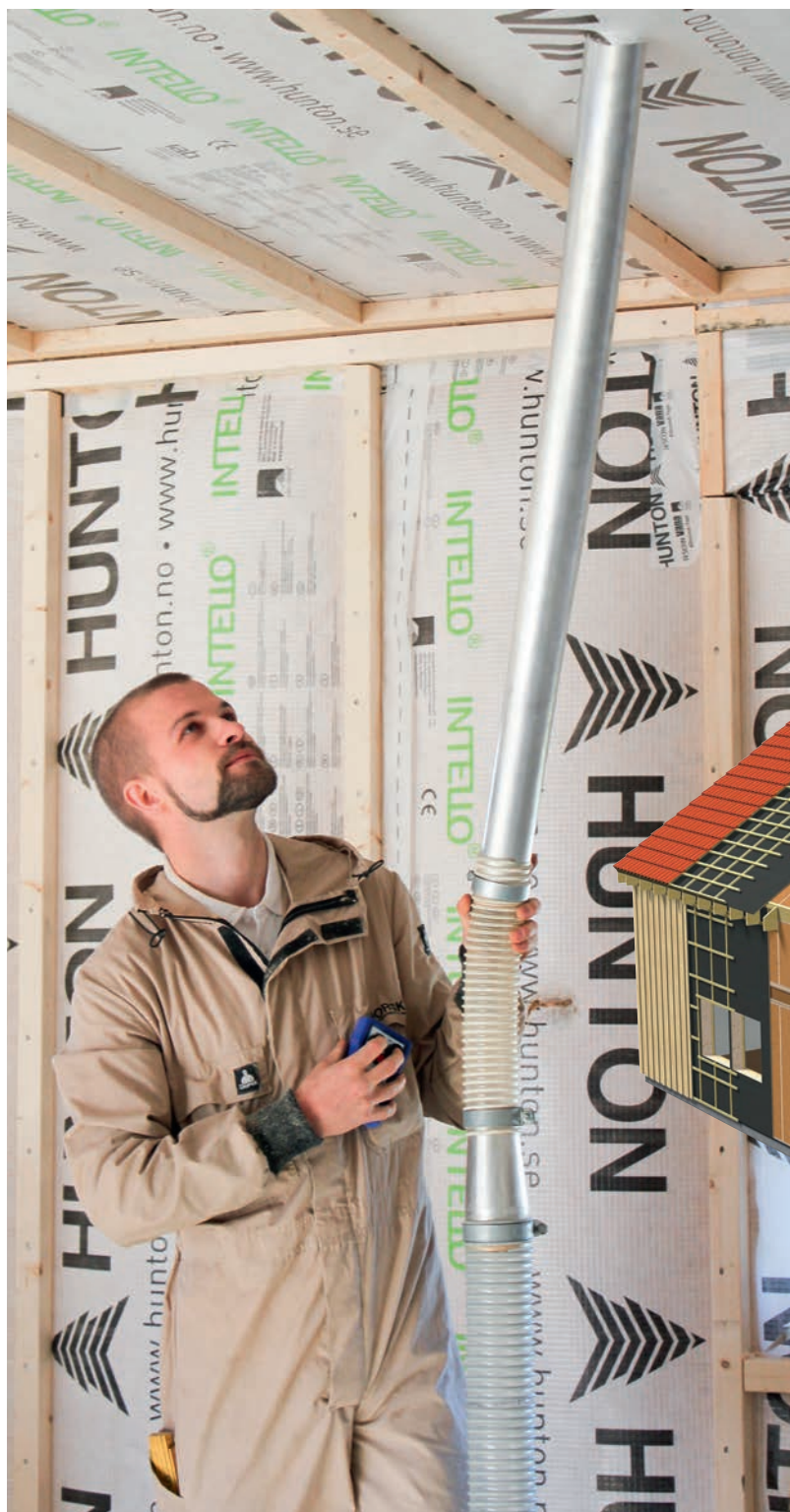
Havainnekuvasssa näkyy Nativo Puukuitueristeellä puhallettu seinä.
